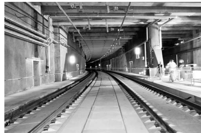
Der Lainzer Tunnel im Abschnitt Altmanndorfer Straße
